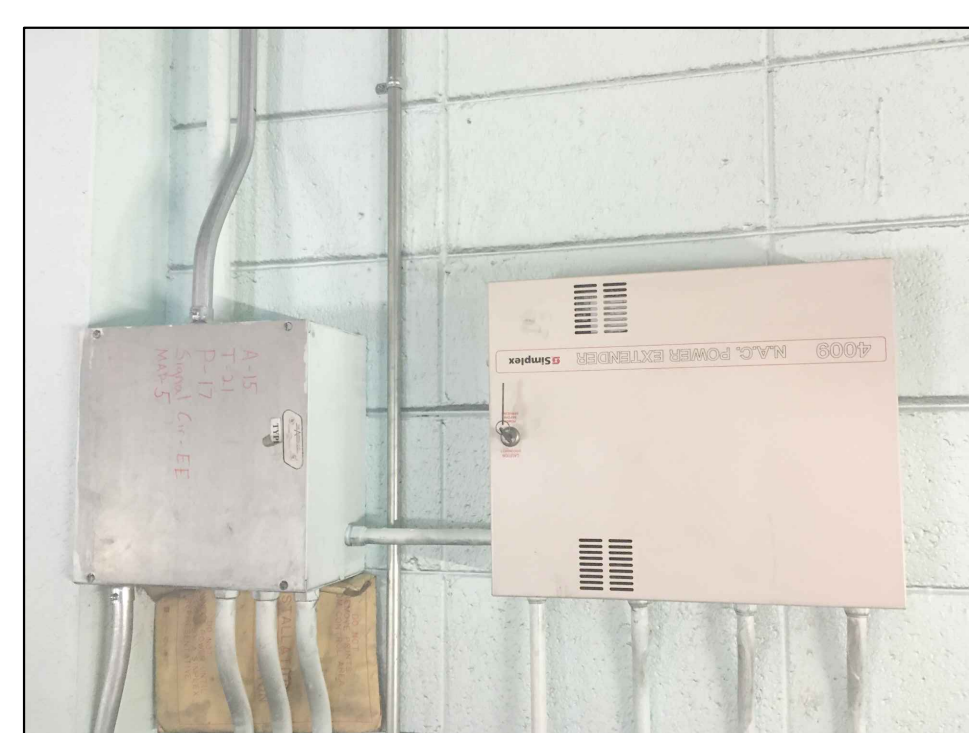
17) FIRE ALARM NAC PANEL
